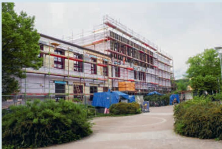
Der Zubau der Volksschule Bad Vöslau schreitet voran. In den vergangenen Wochen wurden die Fensterelemente versetzt und in einer Bestandsklasse die Akustikdecken samt neuer Beleuchtung montiert. Die übrigen Bestandsklassen folgen in den Ferien. Durch diese
