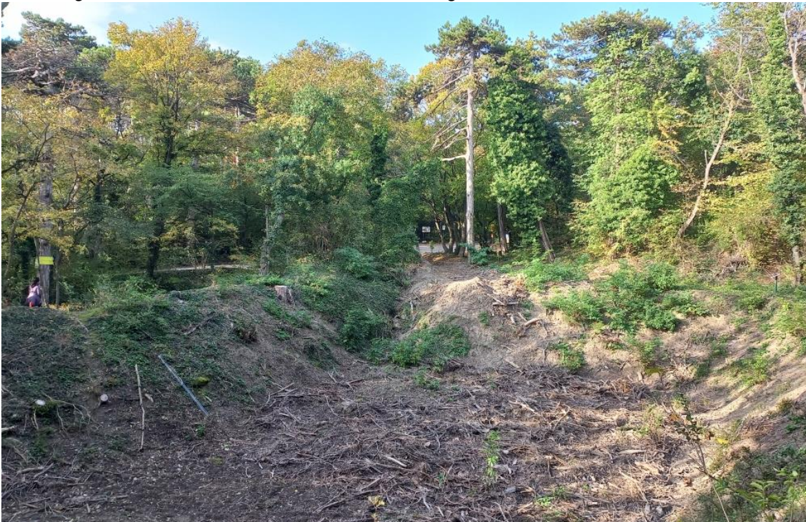
Abbildung 11: Rückhaltemulde im Retentionsraum Lange Gasse
