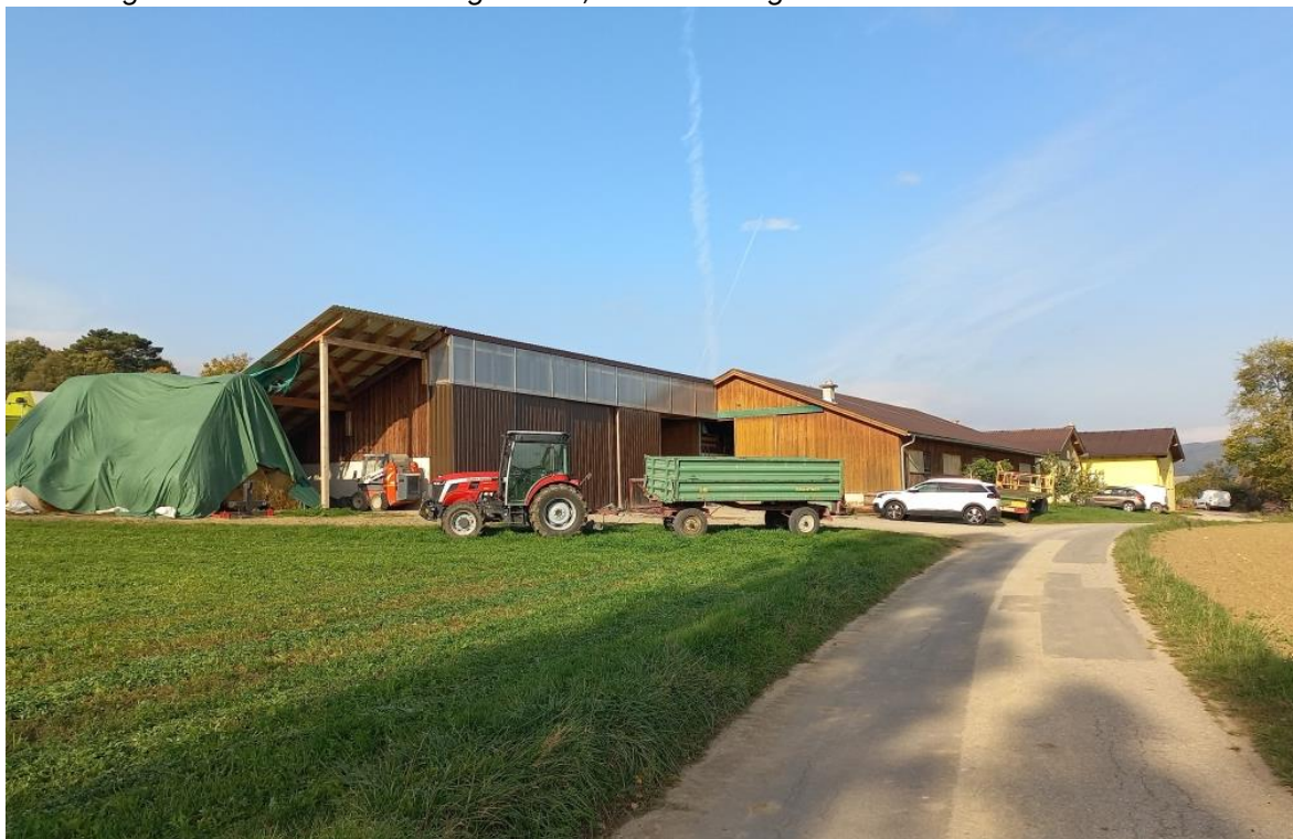
Abbildung 17: Bestehende Betriebsgebäude, Blick Richtung Westen
