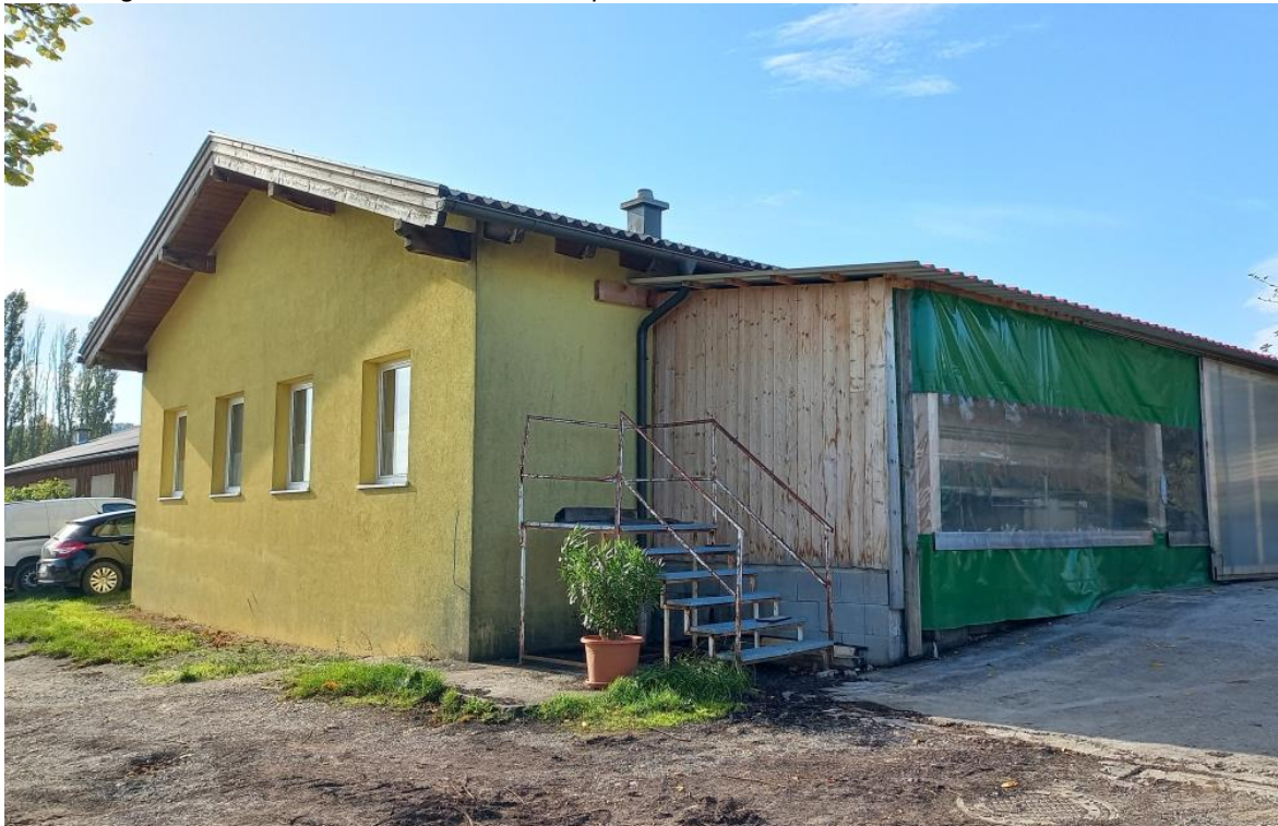
Abbildung 19: Nördliche Betriebsteil für Weinproduktion
